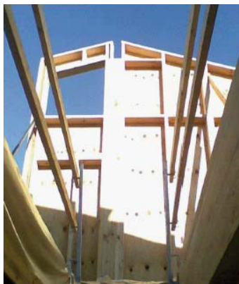
Levage des enveloppes et réalisation du plancher lamellé-cloué
