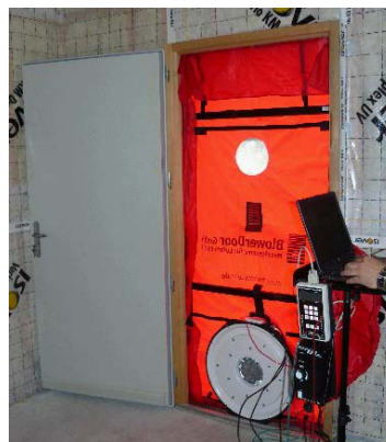
Mesure de la perméabilité à l'air
