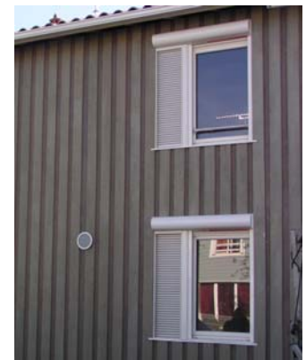
Menuiseries avec volets de ventilation estival et bardages en grande longueur
